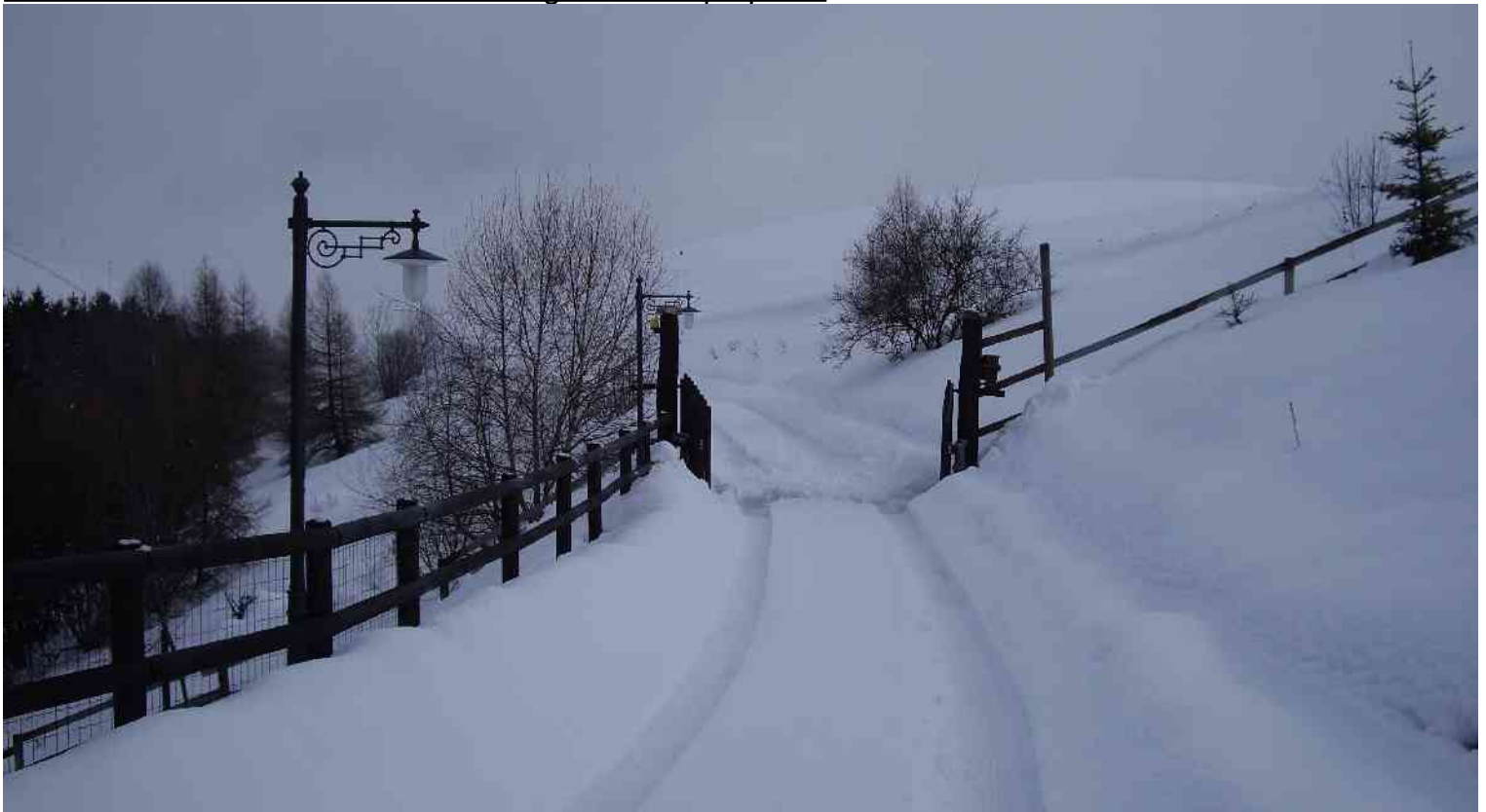
Particolare del cancello automatico d'ingresso alla proprietà
